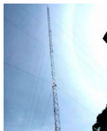
Gambar 3. Pengujian Tower Tri Angle
